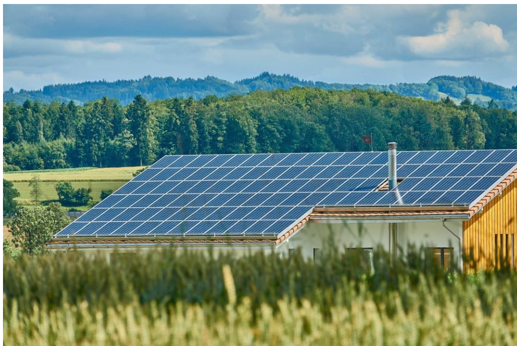
Figura 1.1: Imagen de vivienda residencial con techo fotovoltaico.
